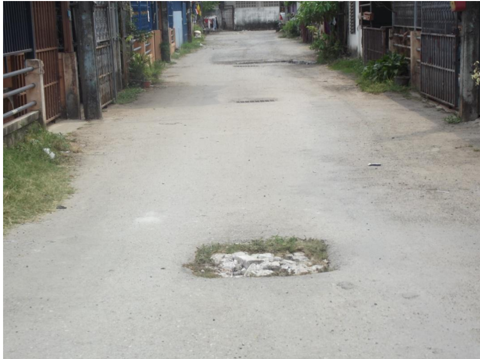
รูปที่ 5.2 ท่อระบายน้ำทิ้งภายในหมู่บ้านเซนการ์เด็นโฮม
